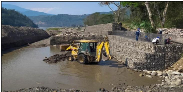
*Nota:* La infografía muestra la construcción de defensas ribereñas mediante gaviones. De "Minagri culmina construcción de defensa ribereña del río Apurímac", por Ministerio de Desarrollo Agrario y Riego (MINAGRI, 2019).
