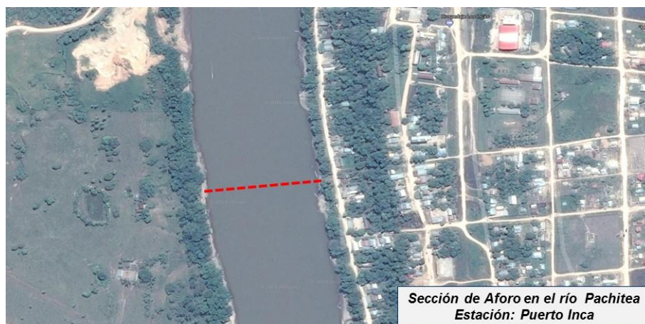
Figura 4.12. Estación Puerto Inca – sección de aforo del río Pachitea Fuente: Elaboración propia
