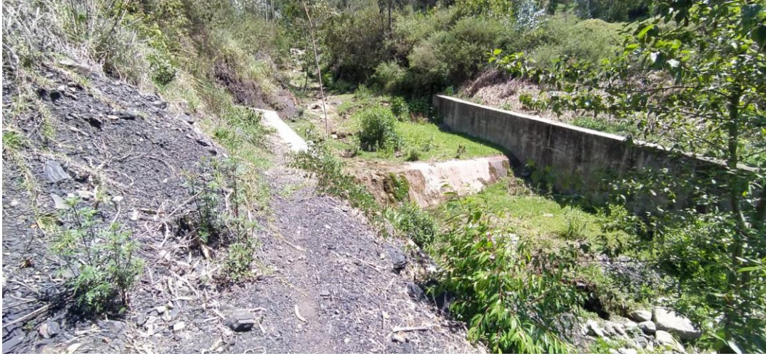
Figura 141 — Estado actual de muros de contención de la quebrada Sahuanay
