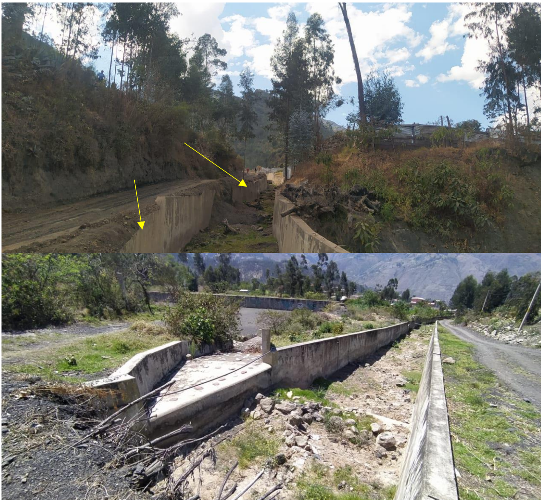
Figura 142 — Estado actual de muros de contención y almacenamiento
