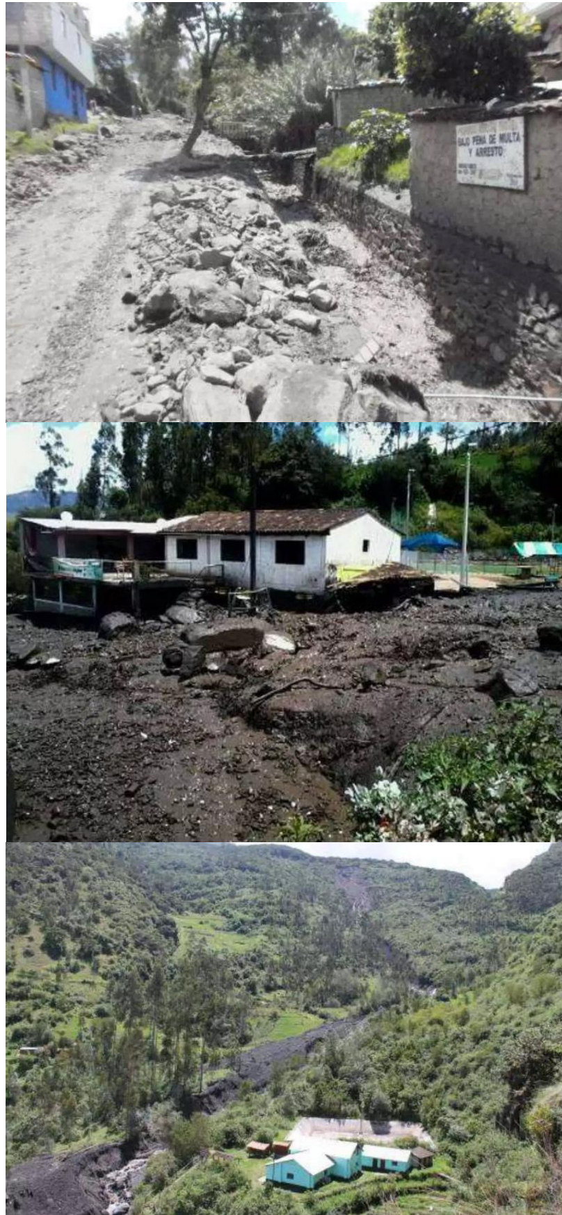
Figura 122 — Flujo de detritos ocurrido el año 2012
