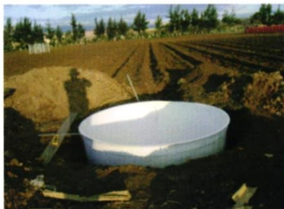
Instalando el tanque evapotranspirómetro
