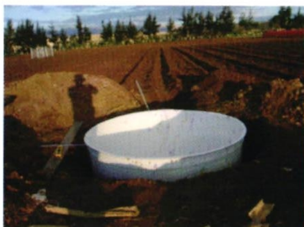
Instalando el tanque evapotranspirómetro
