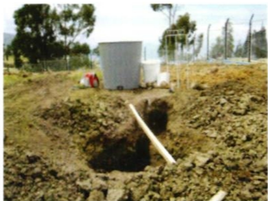
Instalando el tanque evapotranspirómetro
