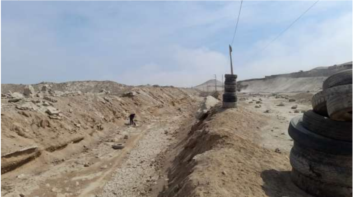
Figura 60. Construcción de la calicata en el lecho natural de la Quebrada Malanche – Punta Hermosa, progresiva 6 + 500.
