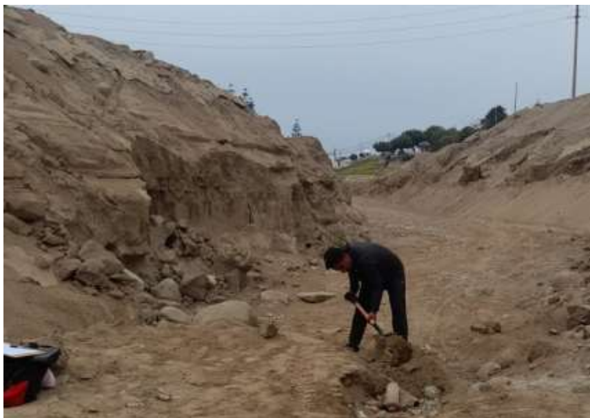
Figura 53. Excavación de calicatas y muestreo en el lecho de la Quebrada Malanche – Punta Hermosa.
