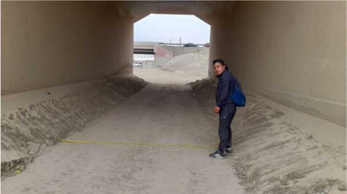
Figura 58. Medición del ancho de la base, del puente Perteneciente a la antigua Panamericana Sur.
