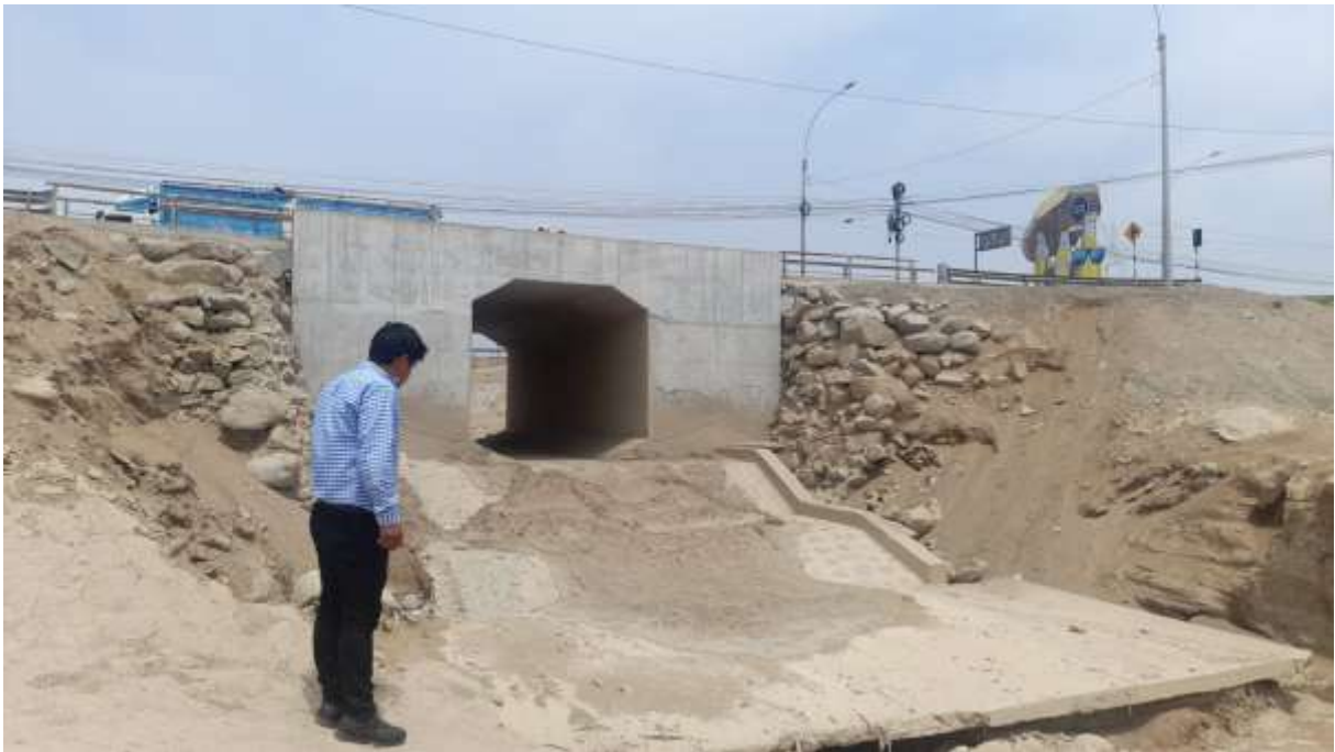
Figura 50: Primera inspección en nuestra visita a campo – Quebrada Malanche.
