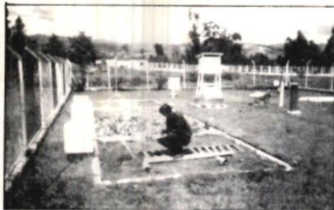
**ESTACION METEOROLOGICA :** El Terreno para instalar una Estación debe ser Plano, nivelado cubierto de cesped corto, libre de maleza u otras Plantas; no deben cultivarse enredaderas sobre las Mayas el Campo debe medir aproximadamente 12 mts. de largo por 8 de ancho orientando de norte a sur.
