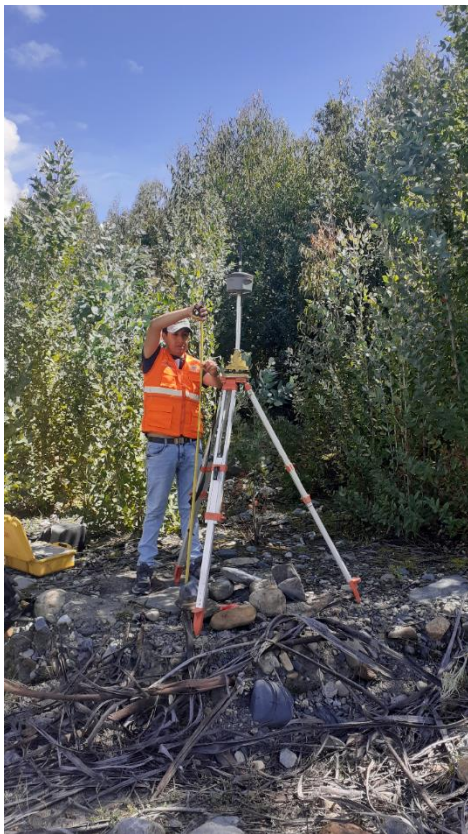
Nota. Medición de altura del equipo.
