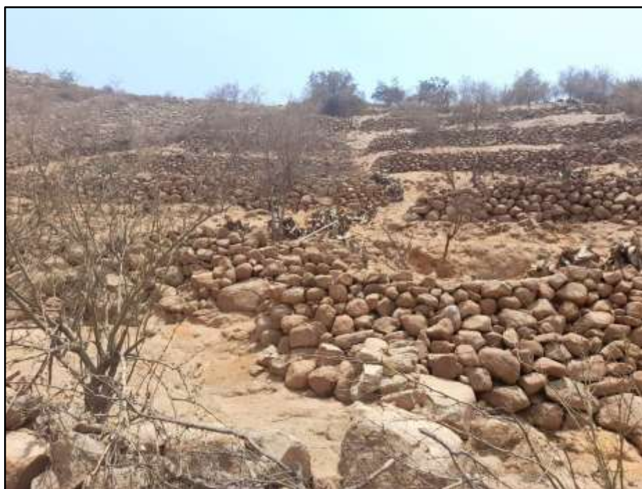
Figura 14-60.- Muros de piedra con parkinsonia.
