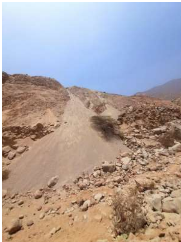
Figura 13-4.- Cono de derrubio en la parte alta de la quebrada de pedregal – laderas fuertemente empinadas, caída de rocas detritus y suelo.
