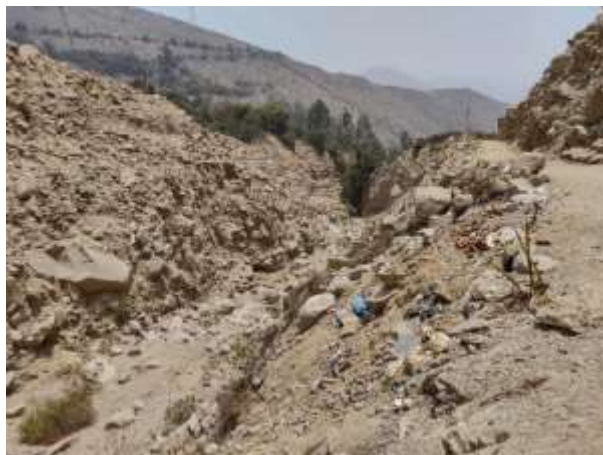
Figura 14-63.- Cauce estrecho de una quebrada tributaria con laderas fuertemente inclinadas y abundante material rocoso expuesto, en las cuales aún se han realizado trabajos de estabilización con geotecnia.
