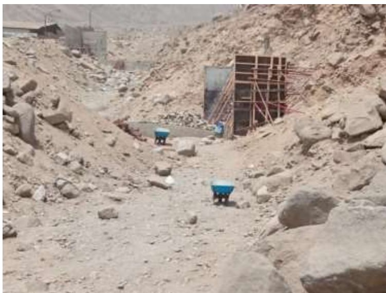
Figura 12-8.- Construcción de Diques de contención a lo largo de la Quebrada Cusipata.
