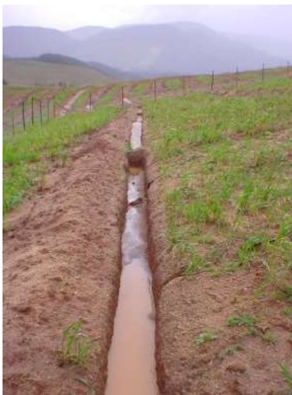
Figura 14-37.- Zanja de infiltración con sus tabiques.
