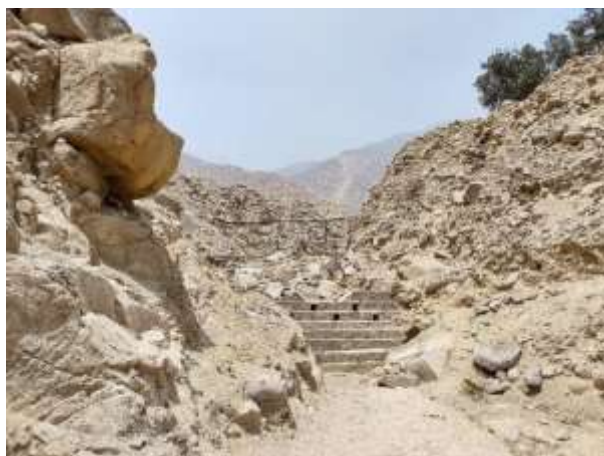
Figura 14-62.- Zona de alto riesgo por caída de rocas, por la pendiente casi vertical y material rocoso fuertemente alterado, puede ocurrir este evento en cualquier momento, si hubiera un movimiento sísmico. Esta roca debió haber sido retirada antes de instalar los diques y las mallas, cuando ocurra este proceso de caída de las rocas quedará el cauce de la quebrada represado.
