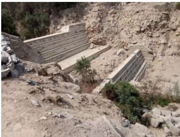
Figura 12-11.- Construcción de diques de mampostería en la parte media de la quebrada Pedregal, la mayoría se encuentran colmatados de sedimentos.
