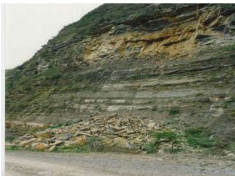
Figura 13-5.- Derrumbe de rocas fuertemente fisuradas, diaclasadas en escarpe de ladera.
