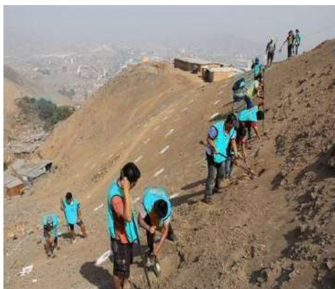
Figura 14-57. Construcción de hoyos en curvas a nivel.
