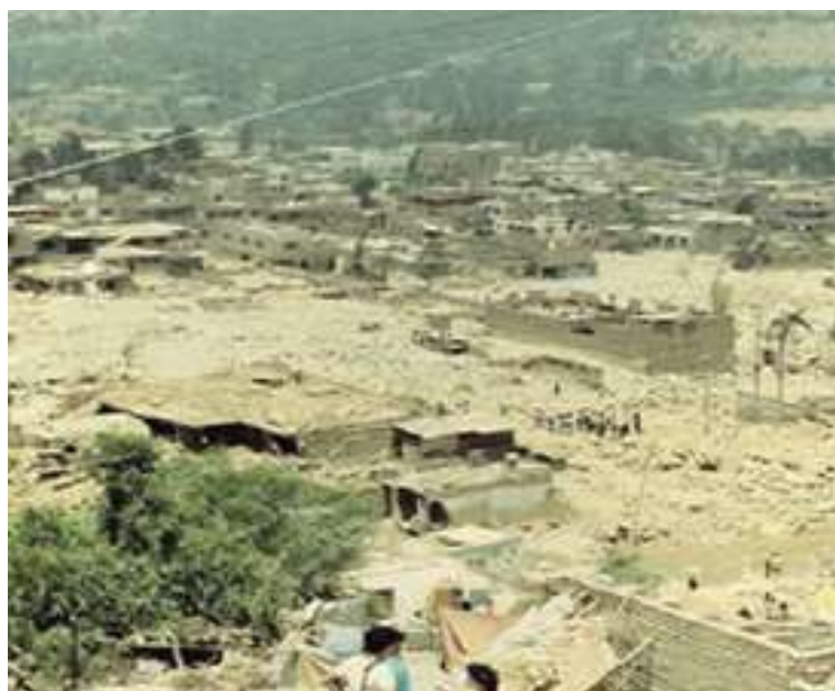
Figura 13-8.- Casas ubicadas en el cono de deyección de la quebrada pedregal en Chosica. Muchas casas fueron destruidas por el huayco que se activó en el año 1987.
