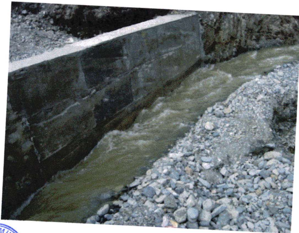
Fotografía 9. Río Llacuabamba muro de contención de concreto en la margen derecha
