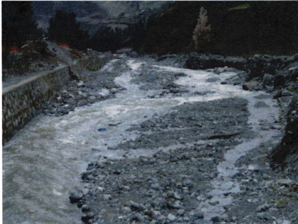
Fotografía 6. Río Llacuabamba flujo al margen de muro de contención
