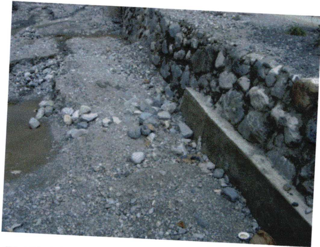
Fotografía 8. Río Llacuabamba muro de contención resanado con concreto
