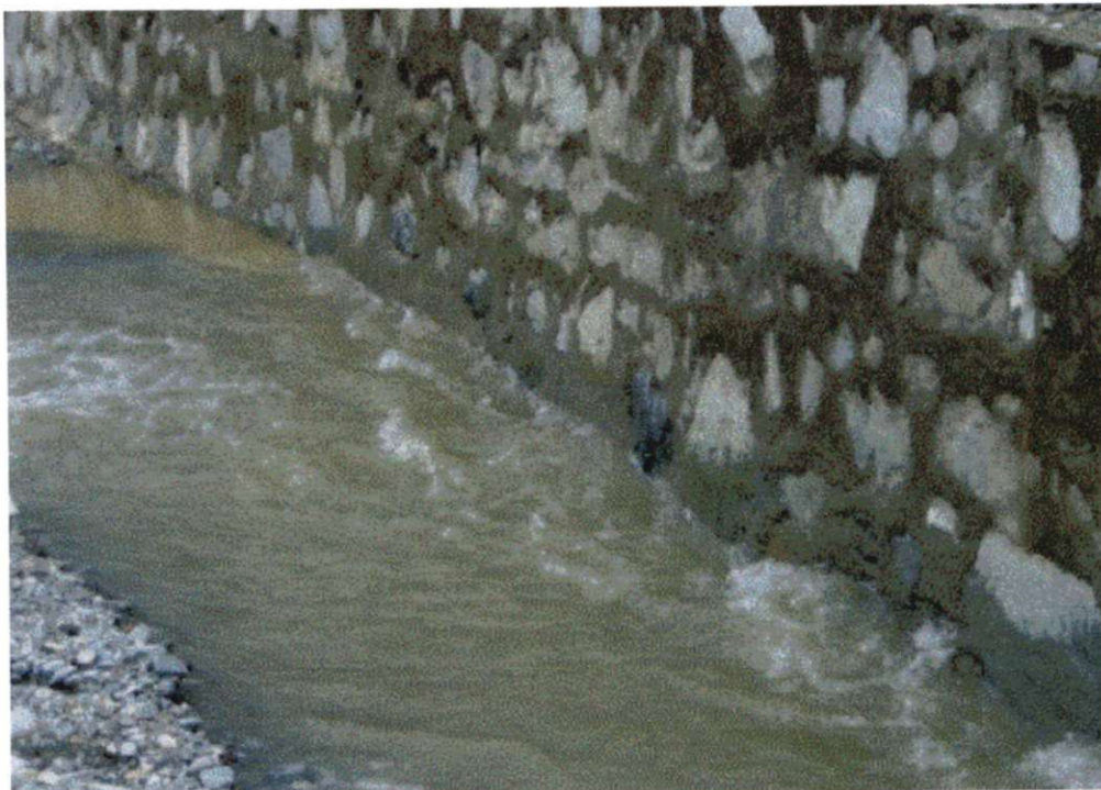
Fotografía 5. Río Llacuabamba infiltración en muro de contención socavado
