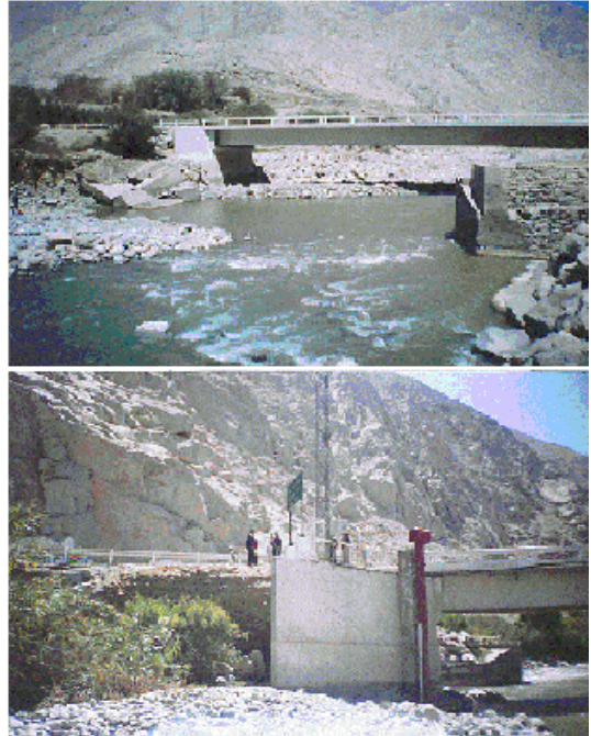
Foto 01: Vista de la Estación H-Letrayoc y aguas arriba de la misma
