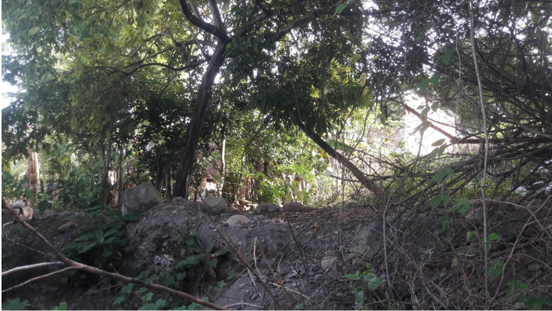
Imagen 17. Se observa obstrucciones como troncos, cercos, por lo que se considera un efecto de las obstrucciones severo
