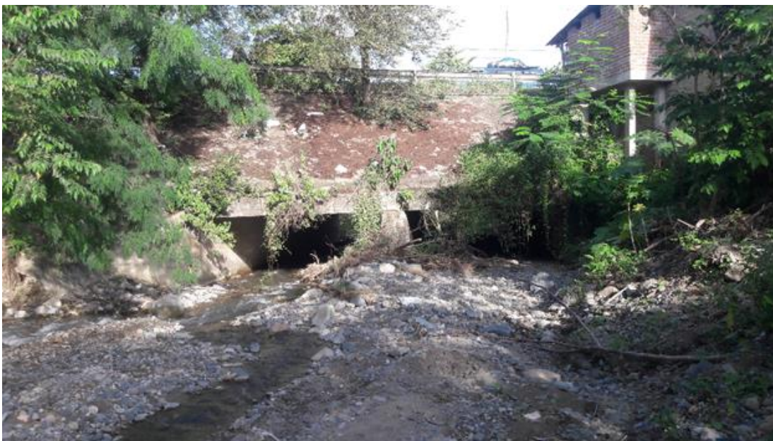
Imagen 12. Puente con pila en el centro, por el que se considera un efecto de obstrucciones menor
