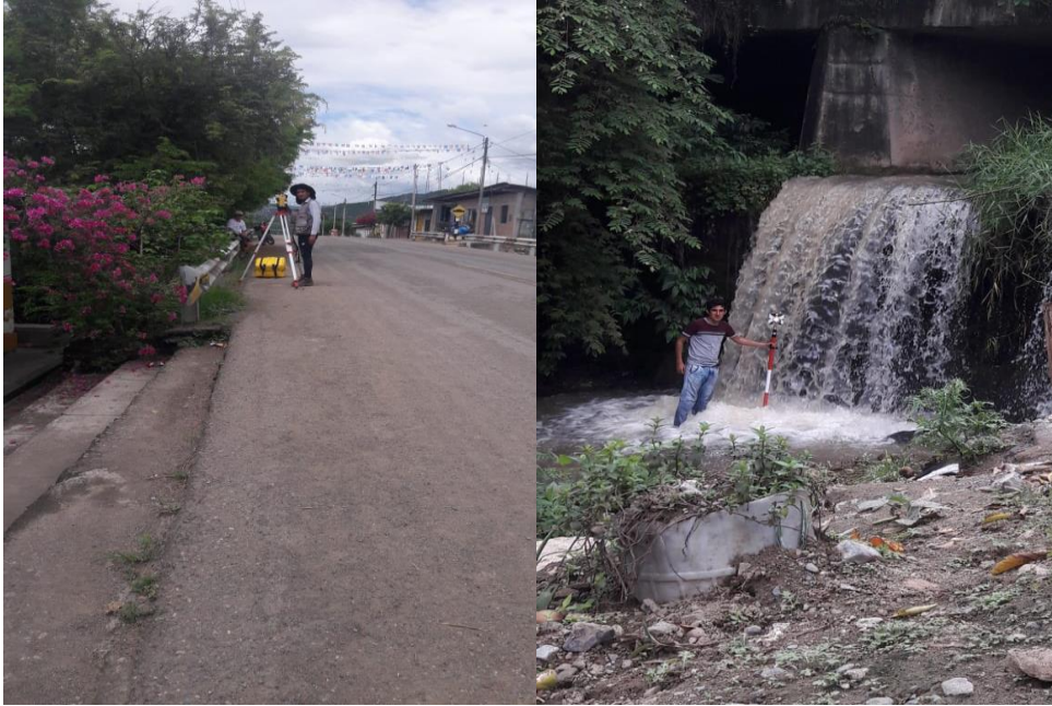
Imagen 3. Estructura existente (Puente carretera Jaén-San Ignacio)
