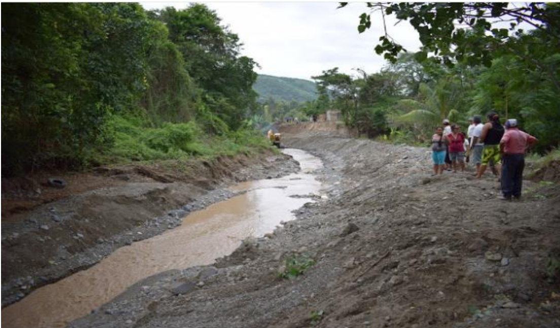
Imagen 8. Zona en la que ocurre desborde de las aguas – progresiva 0 + 320 Km del plano de inundación
