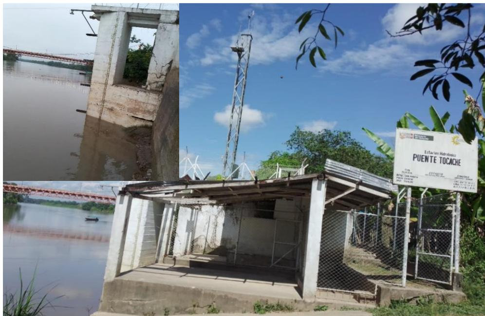
**Foto 14:** Vista de la estación HLM/EHA Tocache, en la parte superior izquierda la escala limnimétrica y sensor radárico
