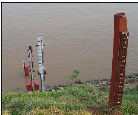
Foto 3: Estación HLM Chazuta/Huallaga Fuente: Banco de fotos - DGH
