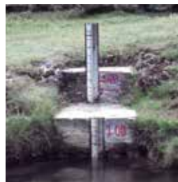
Estación hidrológica limnimétrica
