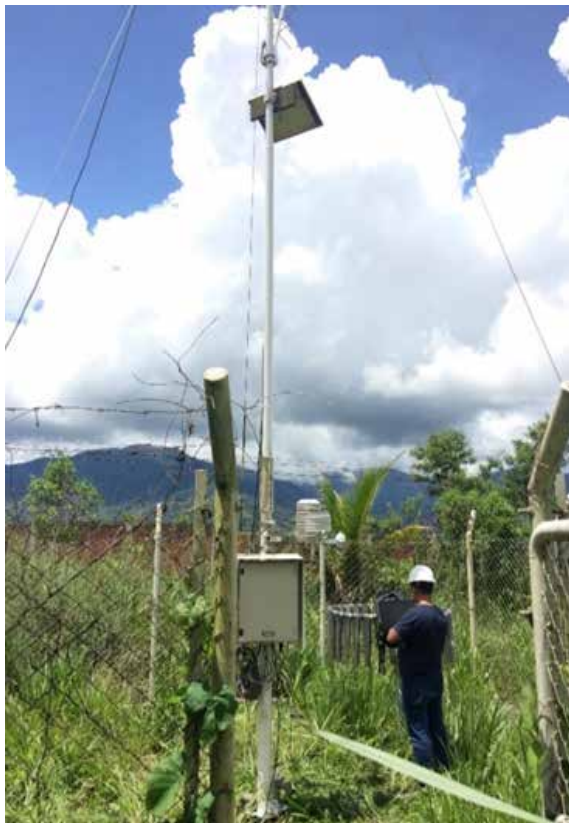
Instalación de sensores, ajuste de conexión eléctrica en la Estación EMA GUZMANGO
