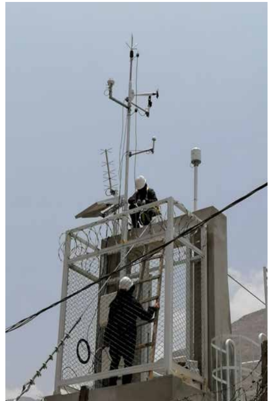
Rehabilitación Estación EHA Río Corral del medio (DZ10)
