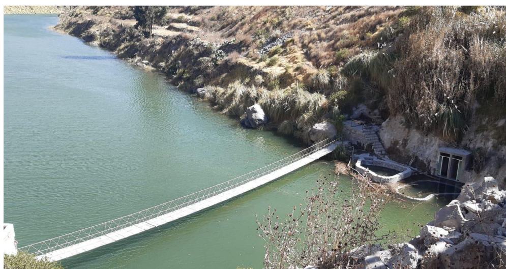
Figura 13. Puente en Baños termales de Chacapi (28 de junio)
