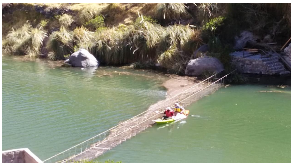
Figura 14. Puente en Baños termales de Chacapi (30 de junio)
