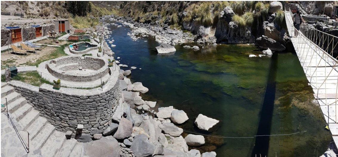
Figura 15. Puente en baños termales de Chacapi en condiciones normales
