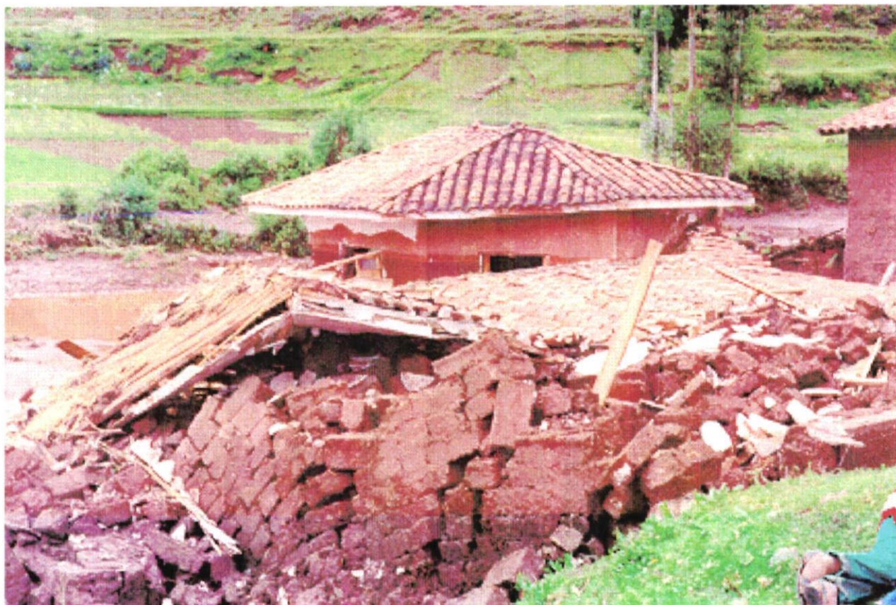
FIG. 3.- CASA DESTRUIDA EN TAMBURCO-APURIMAC, POR INUNDACIONES Y HUAYCOS. FOTO: DGM-SENAMHI
